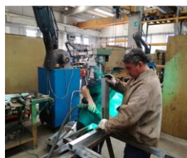
Fig. 9 – fase di saldatura dei profili
